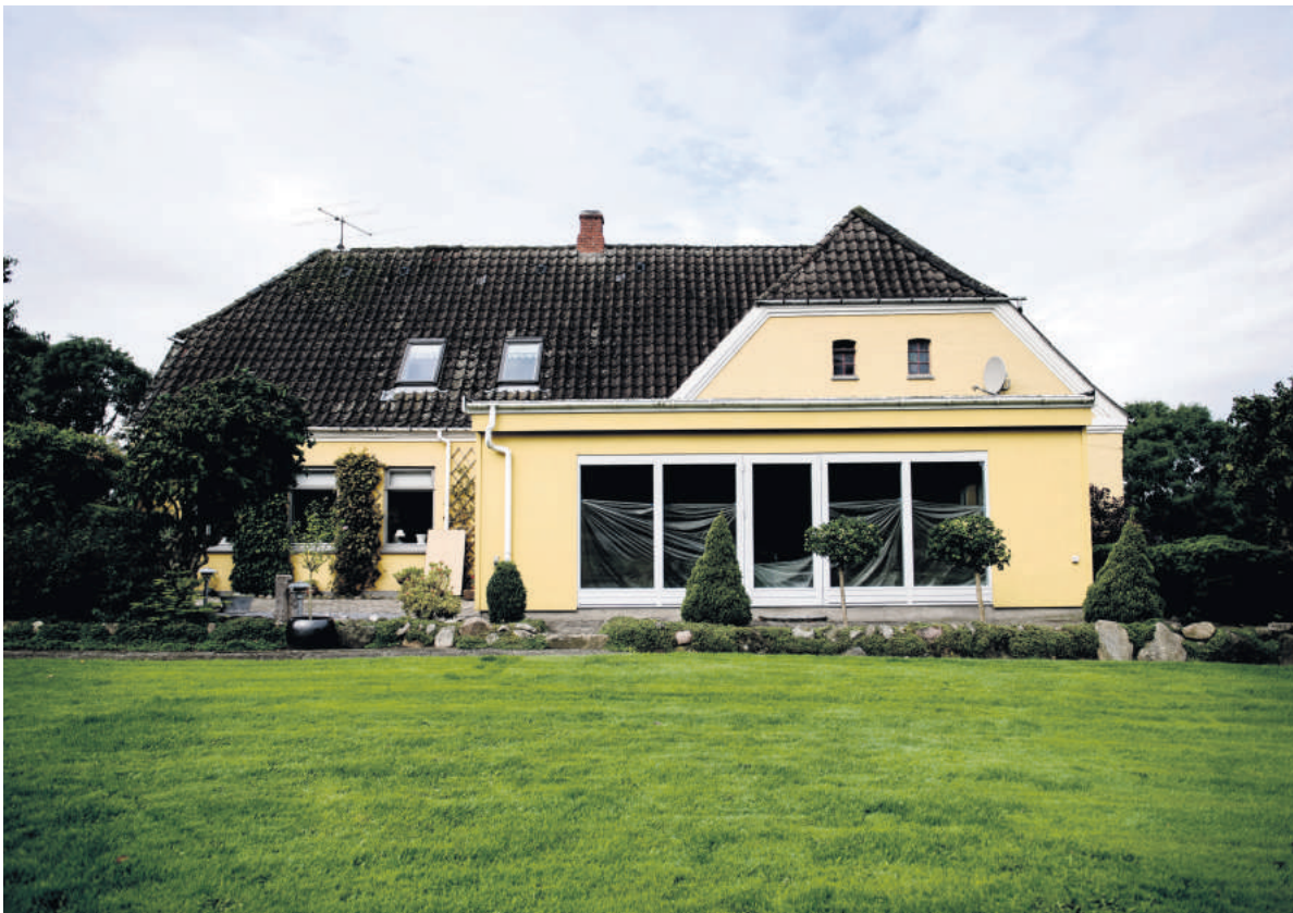
Den gamle ejendom med Svend Aage og Irenes tilbyggede havestue, som nu får gulvvarme.
