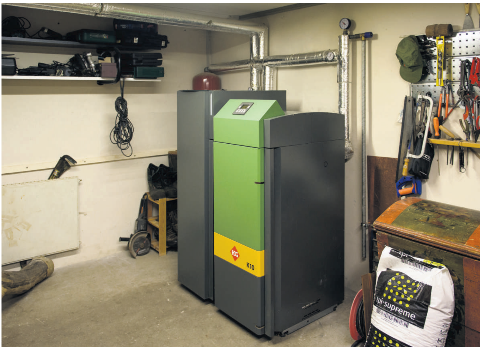
Træpillefyret - med træpillesiloen - fylder det samme som to køkkenskabe.
